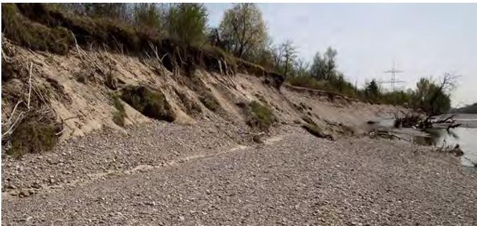
*Abbildung: Der Rückbau von Ufersicherungen soll die starren Ufer aufweiten und dadurch die weitere Eintiefung des Lechs verhindern. (Hier Uferanbruch nördlich Gersthofen)*
