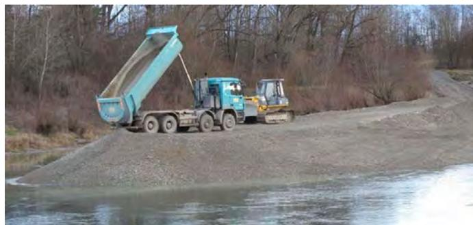
*Abbildung: Externe Kieszugaben stabilisieren die Flusssohle.*
